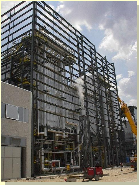
Fase di costruzione struttura di parete
